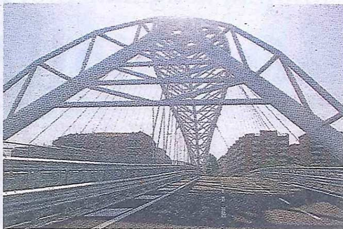
Il ponte Ostiense, 2 mila tonnellate di acciaio per 160 metri di lunghezza
