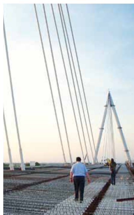
Figura 17a - Vista d'insieme degli stralli di sostegno della campata centrale
