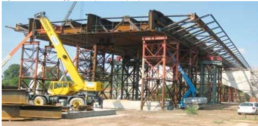
Figura 12 - Assiemaggio dell'impalcato su pile provvisorie e rulliere di varo
