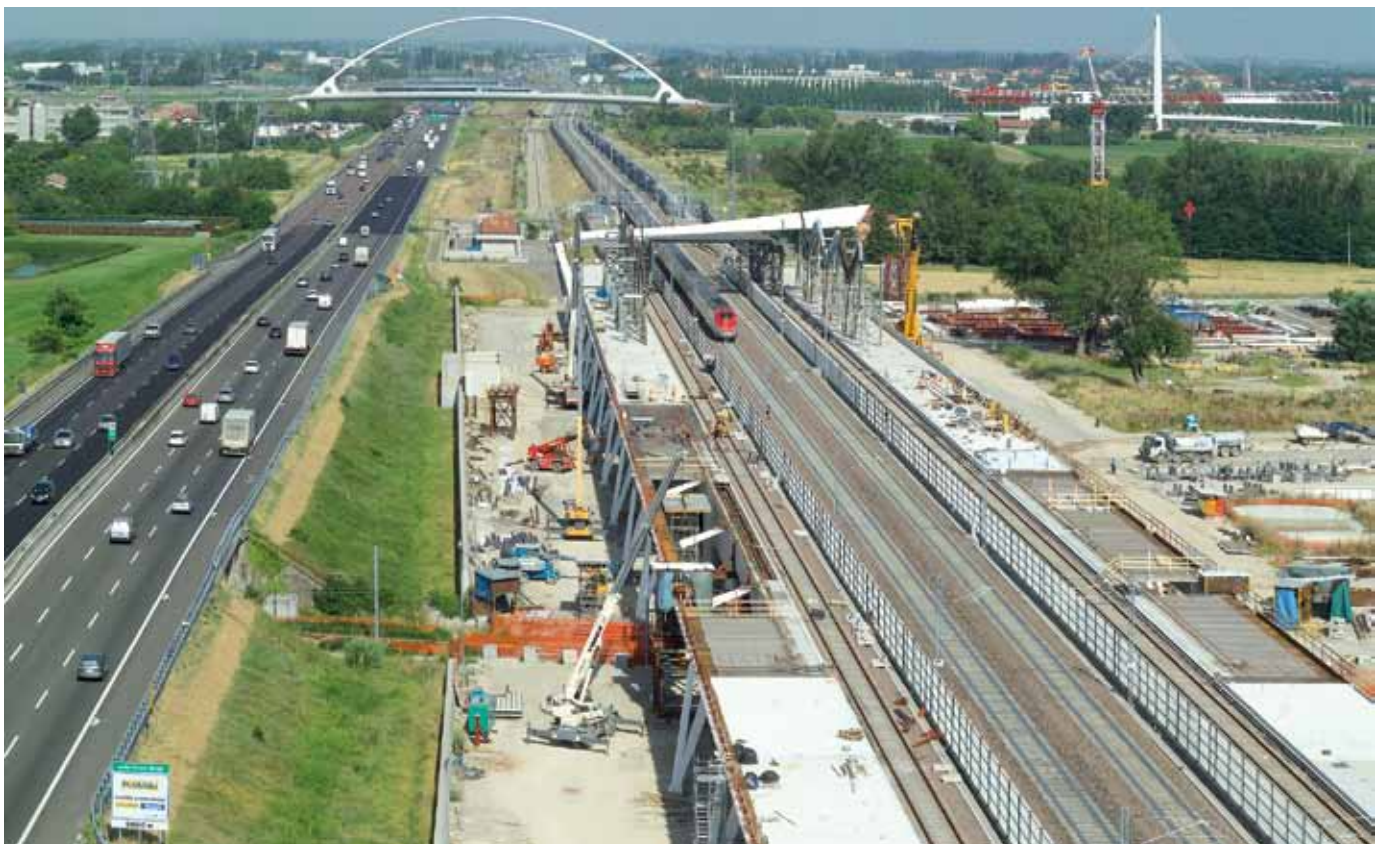
Foto aerea di inquadramento dell'area nord in corrispondenza del cantiere della stazione Mediopadana AV di Reggio Emilia - foto Carlo Vannini
