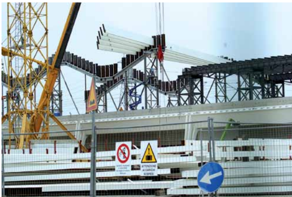
La stazione Mediopadana di Calatrava, fasi di montaggio della copertura
