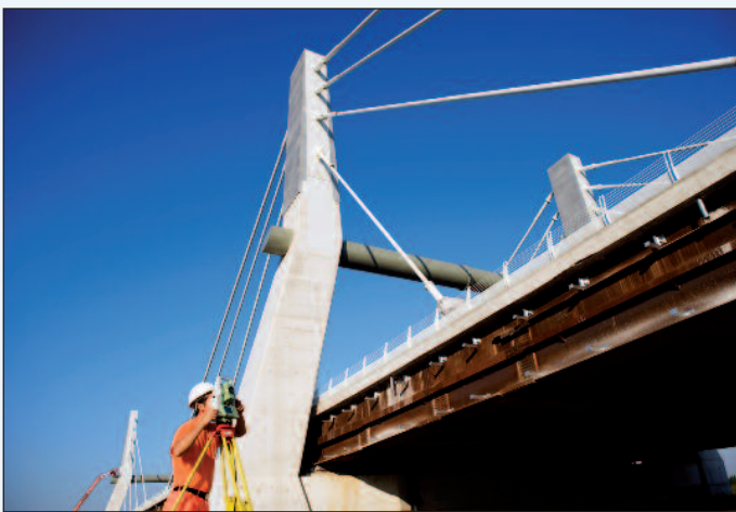
Figura 11 - Il controllo degli stralli
