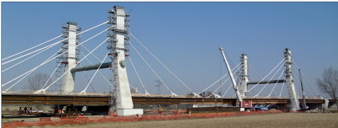
Figura 6 - Il montaggio del ponte strallato
