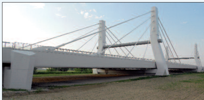
Figura 8 - Il completamento montaggio del ponte strallato
