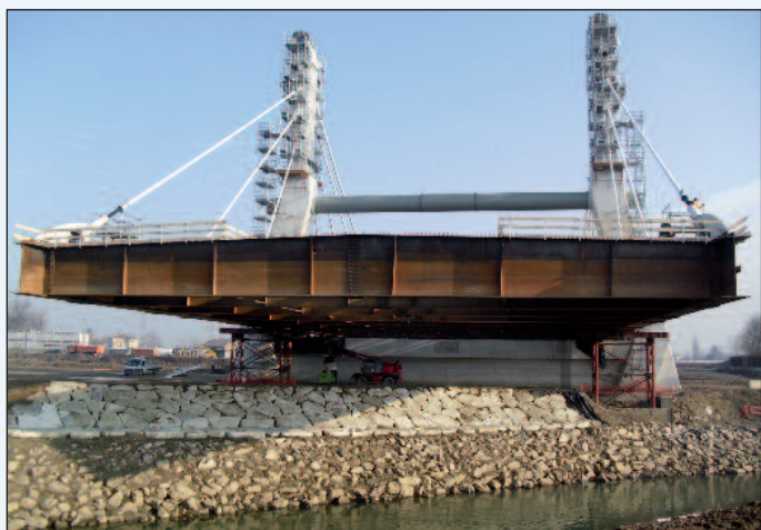
Figura 7 - La fase di montaggio a sbalzo del ponte strallato
