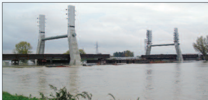
Figura 9 - L'area di cantiere durante l'alluvione
