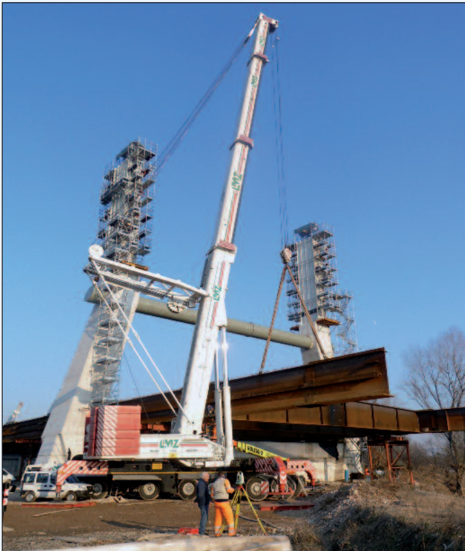
Figura 10 - La verifica dei target durante le fasi di montaggio
