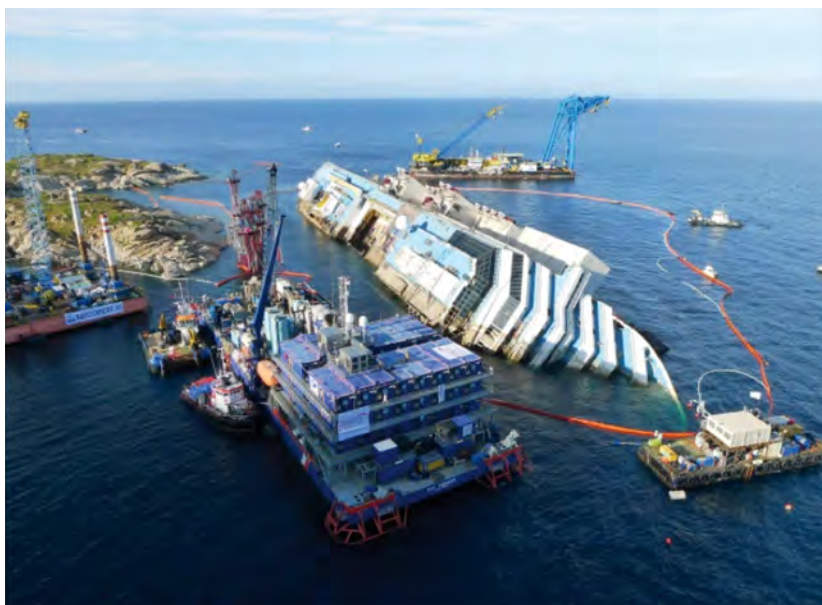
Fig. 1 - La Concordia nelle fasi iniziali della rotazione (16 settembre 2013)
