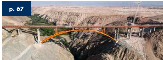
La Joya Bridge 2023 Arequipa - Perù - 371 m total length
