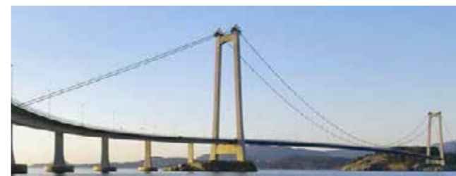
Puente Bomla Stord - Noruega - Longitud 500 m 2000
