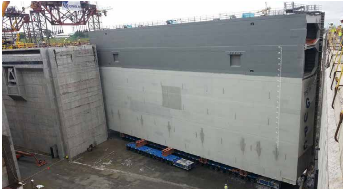
SPMT - Carros tipo MSPE EVO 2 - Más de 160 ejes disponibles - Capacidad de carga total de 9,500 toneladas.
