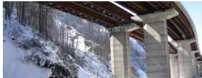
Viaductos sobre la autopista Istanbul-Ankara Turquía - Longitud 2.300 m 2007
