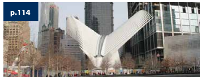
Nueva estación WTC 2015 Nueva York - Estados Unidos - Área Cubierta 3.000 m 2
