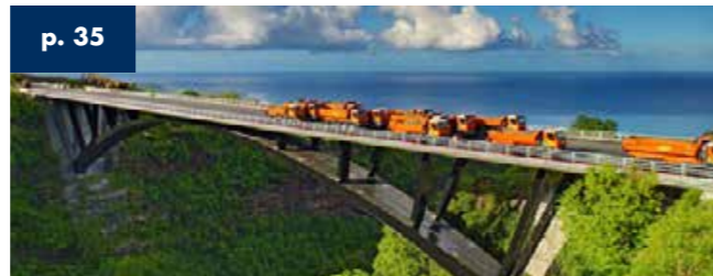
p. 35 Puente sobre el Ravine Fontaine St. Leu - Isla de Riunion - Longitud 200 m 2009
