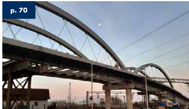
p. 70 Paso elevado ferroviario Vinkovci - Croazia - Longitud 210 m 2023
