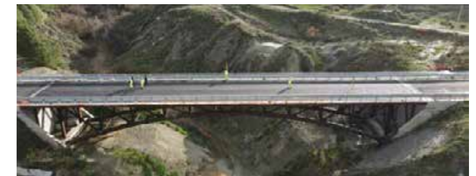
Puente en Pisticci Matera - Italia - Longitud 60 m
