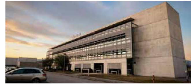
CIMOLAI SpA - Porcia - Italia SEDE
