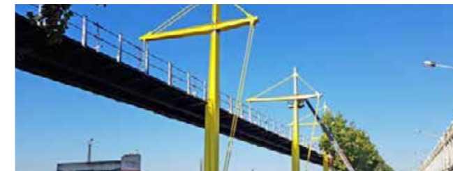
Passerella Ciclopedonale PC8 2023 Esch sur Alzette - Gran Ducado de Luxemburgo - Longitud 1.700 m
