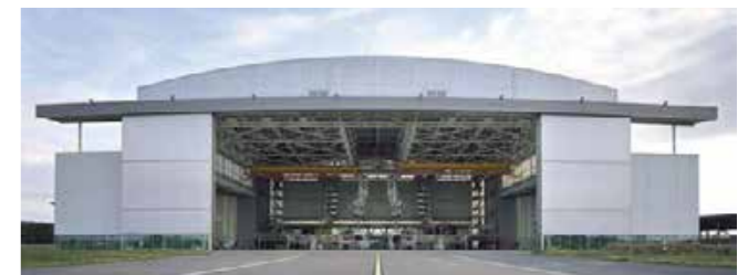
Hangar de mantenimiento Roissy en France - Francia - Área cubierta 10.000 m 2 2008
