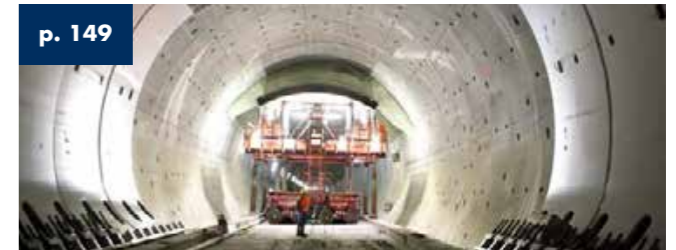
Galeria Sparvo Autopista A1 - Italia - Longitud 540 m
