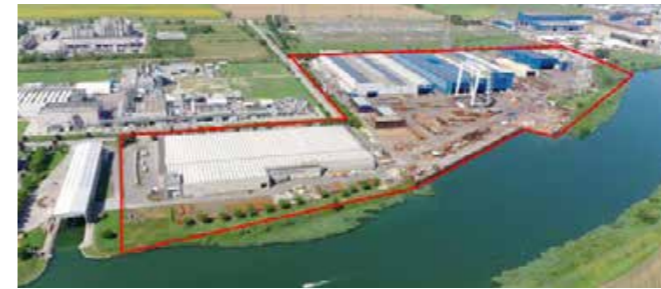
CIMOLAI SpA - S. Giorgio di Nogaro - Italia Área Total 180.000 m 2 - Área Techada 60.000 m 2
