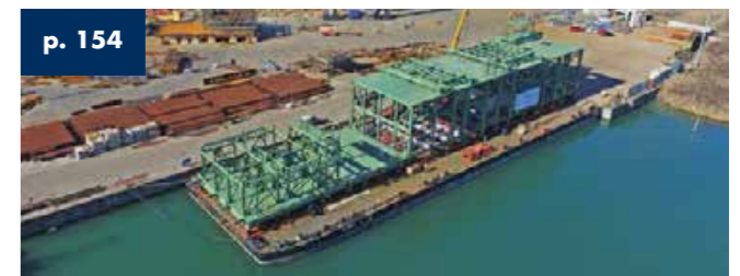
Estructuras On Shore - Tengiz Kazakjstan - Cantidad módulos 20
