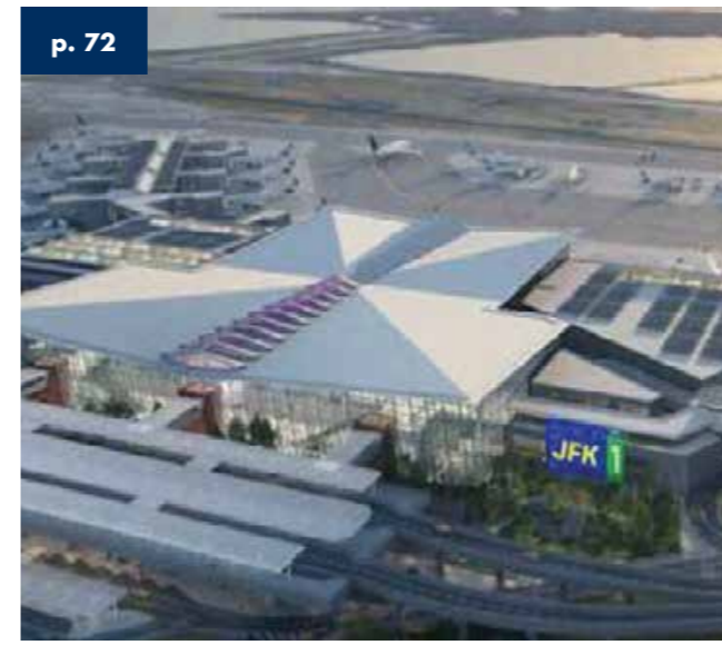
p. 72 Puente JFK T1 New York - USA - Longitud 460 m 2023
