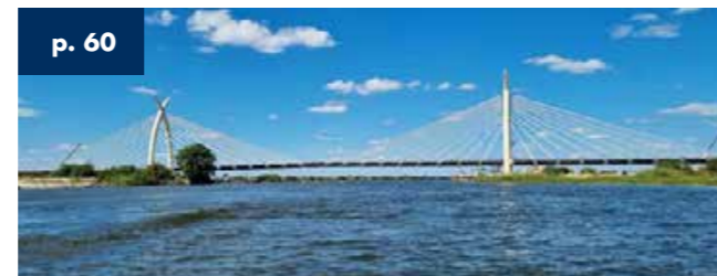
p. 60 Puente sobre el Okavango Mohembo - Botswana - Longitud 1.161 m 2022
