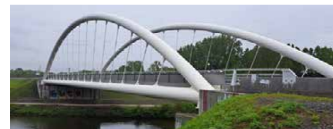
p. 62 Puente OA7 Valenciennes - Francia - Longitud 75.5 m 2022
