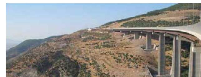
Viaductos sobre la autopista Adana Gaziantep Turquía - Longitud 5.200 m 1999
