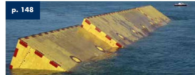
Mo.s.e. - Bocca di porto di Lido Venecia - Italia - Cantidad compuertas 23
