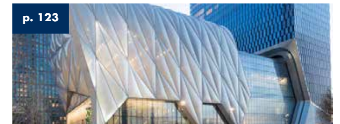
Hudson Yards - The Shed 2019 Nueva York - Estados Unidos - Área Cubierta: 3.293 m 2
