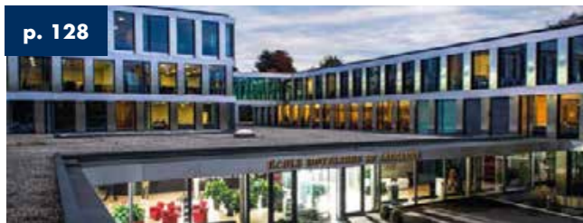
p. 128 La verrière de l'école hôtelière de Lausanne Losanna - Suiza - Área Cubierta 2.500 m 2 2021
