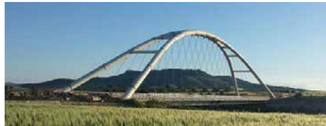
Puente sobre el Gravina Cr. Estatal Bradanica - Italia - Longitud 144 m
