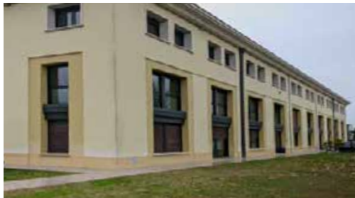
CIMOLAI Balneario - Padova - Italia OFICINA
