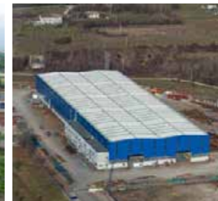
CIMOLAI SpA - Artugna - Italia Área Total 85.000 m 2 Área Techada 12.000 m 2
