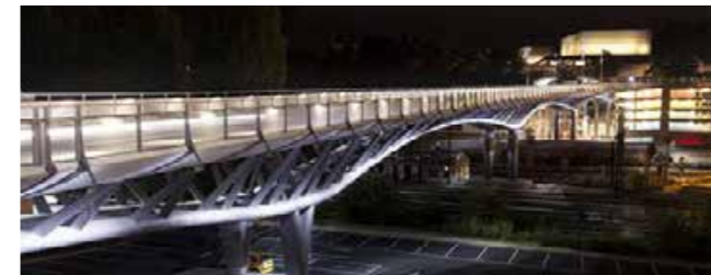
Viaducto Leon Blum Poitiers - Francia - Longitud 310 m 2013
