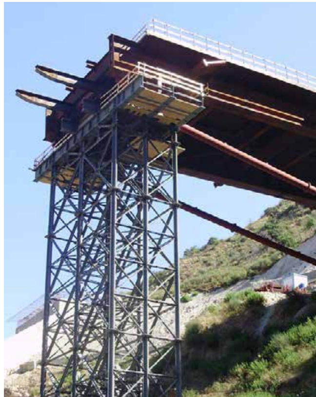
TORRES PROVISIONALES - De sección cruciforme o circular.
