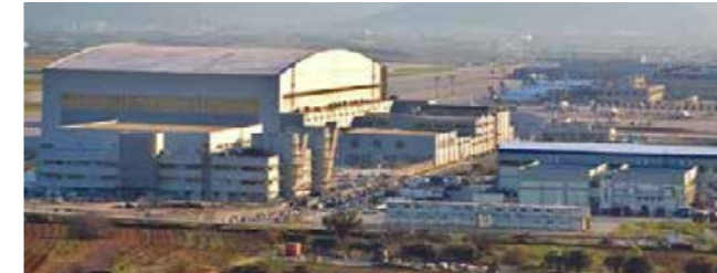
Hangar de mantenimiento Atenas - Grecia - Área cubierta 24.000 m 2 2001
