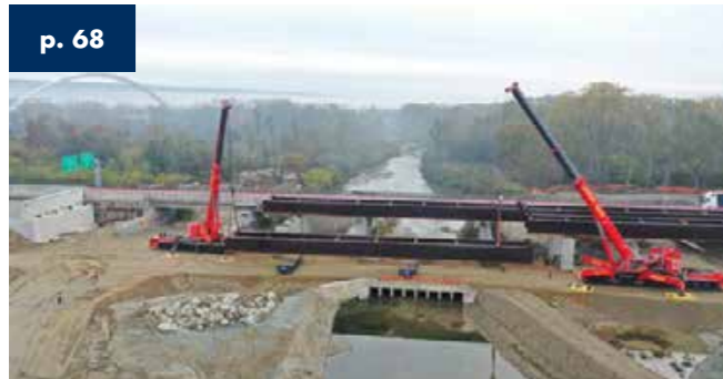
p. 68 Puente sobre Chiusella Autopista A5 - Italia - Longitud 292 m 2023
