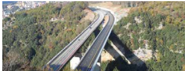
Viaducto Serra Autopista A3 - Italia - Longitud 230 m
