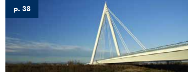
p. 38 Puente sobre el Adige Valdastico sur - Italia - Longitud 1.000 m 2010
