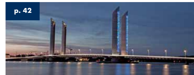
p. 42 Puente Jacques Chaban Delmas Bordeaux - Francia - Longitud 430 m 2013
