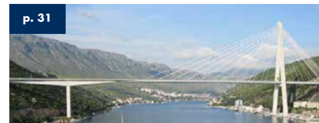
Puente Franjo Tudjman Dubrovnik - Croacia - Longitud 314 m 2001
