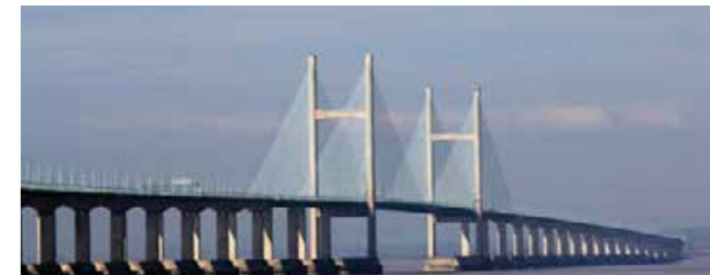
Puente Second Severn Bristol - Reino Unido - Longitud 2.140 m 1994
