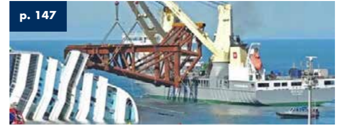
Plataforma de remoción Costa Concordia Isla del Giglio - Italia - Dimensiones 35 m x 45 m x 20 m
