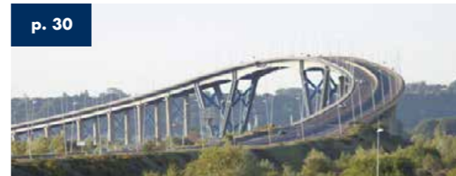
Viaducto sobre el Grand Canal Maritime Le Havre - Francia - Longitud 1.410 m 1994
