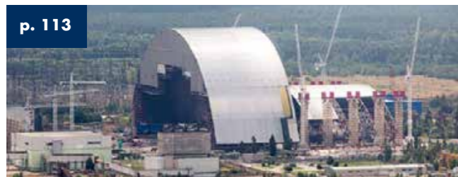
Nuevo Sistema de Contención 2015 Chernobyl - Ucrania - Dim. 257 m x 150 m x 109 m
