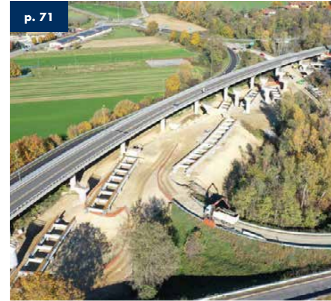
p. 71 Viaducos de la circunvalación de Fossano Tramo S.S. 231 "di Santa Vittoria"- Italia - Longitud 780 m 2023
