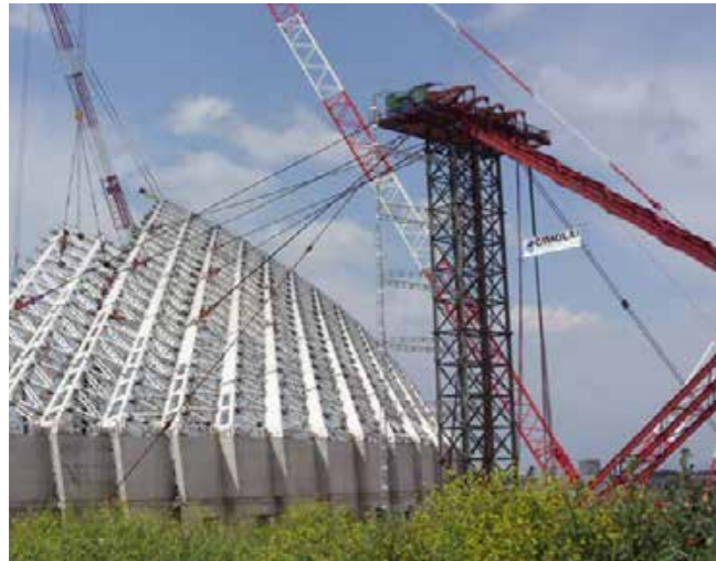
TORRES PROVISIONALES - De sección cruciforme o circular.
