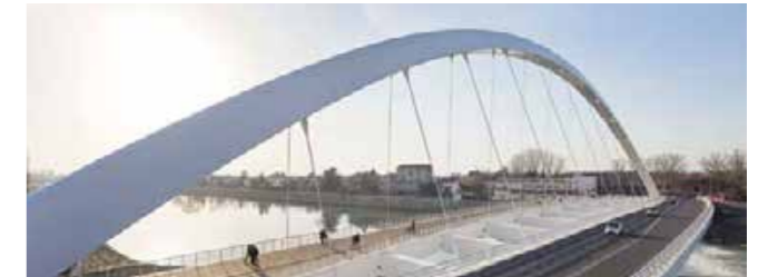
Puente Cittadella Alessandria - Italia - Longitud 185 m
