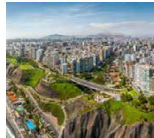
CIMOLAI SpA - Lima - Peú OFICINA
