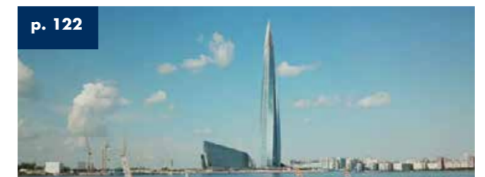
Torre del centro Lakhta Center 2018 S. Petersburgo - Rusia - Alto 462 m
