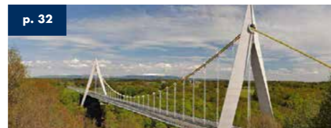
Viaducto Chavanon Merlines - Francia - Longitud 360 m 2001
