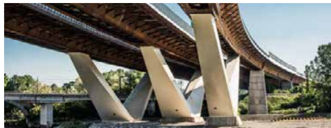
Viaducto sobre el Lambro Autopista A1 - Italia - Longitud 4.000 m
