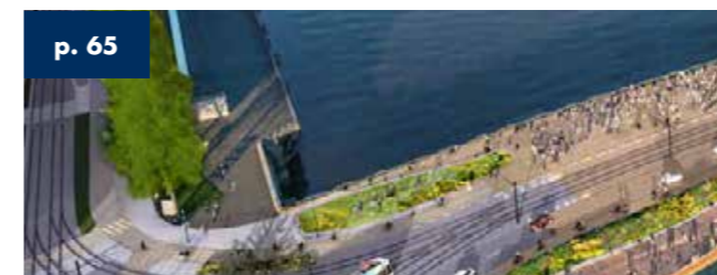
p. 65 Puente Anne De Bretagne Gonesse - Francia - Longitud 140 m 2023
