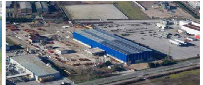
CIMOLAI SpA - S. Giorgio di Nogaro 2 - Italia Área Total 95.000 m 2 - Área Techada 12.000 m 2
