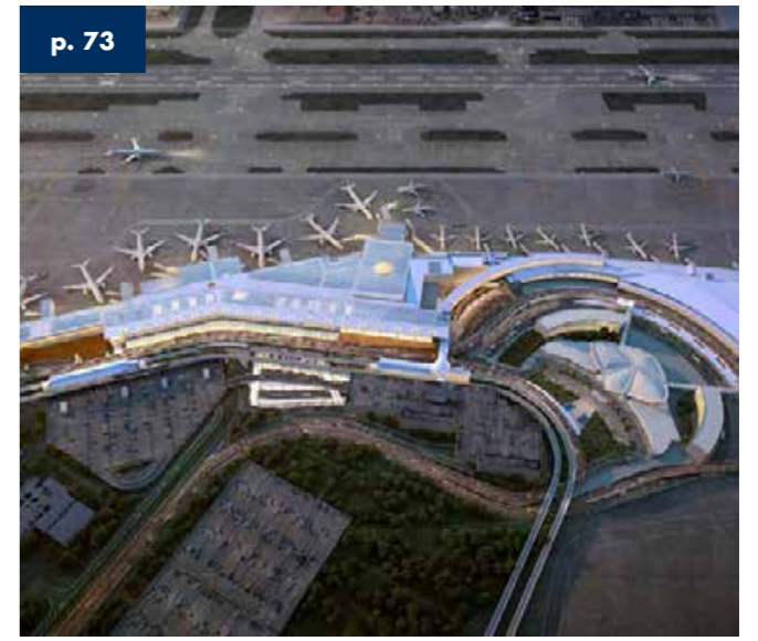
p. 73 Reestructuración del puente JFK T6 New York - USA - Longitud 903 m 2023
