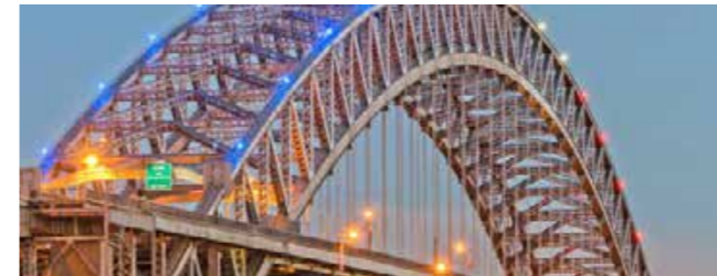
Puente Bayonne Nueva York - Estados Unidos - Longitud 510 m
