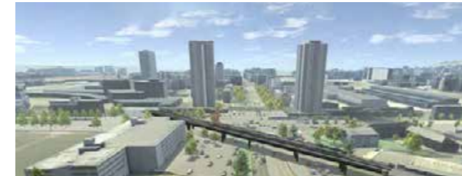
CDG Express - Zone C - Porte de la Chapelle 2022 París - Francia - Longitud 296 m
