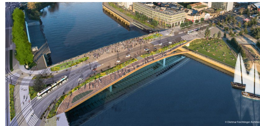
Pont Anne de Bretagne Ongoing Nantes - France
