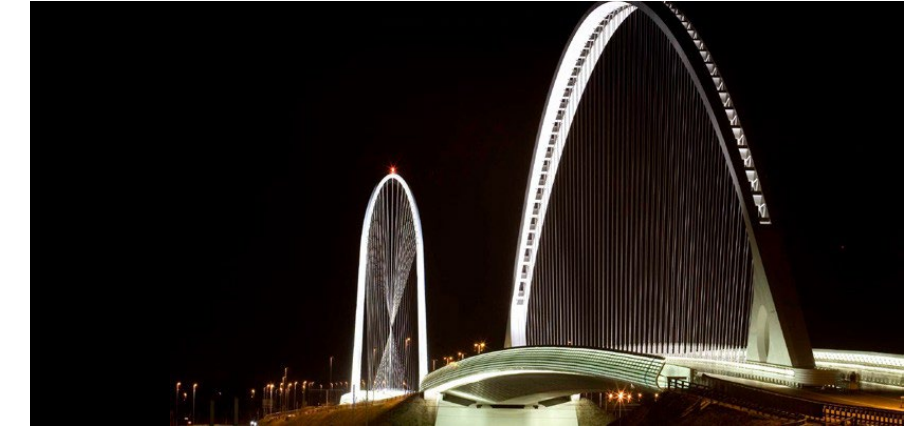
Viadotti Reggio Emilia 2006 Autostrada A1 - Italy
