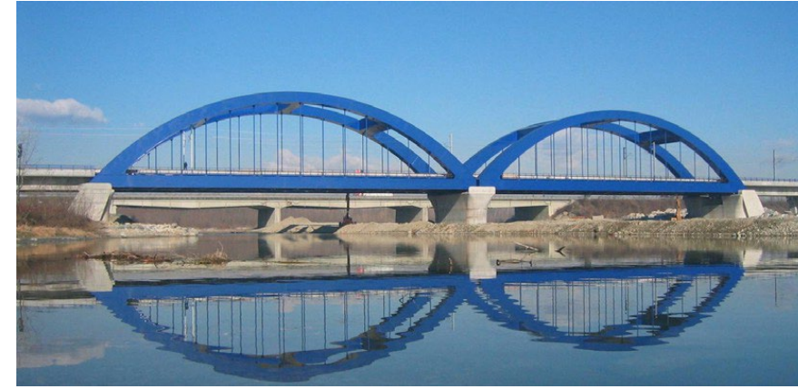
Dora Baltea Viaduct 2004 Rondissone - Italy
