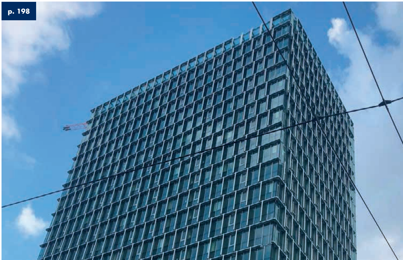
Piraeus Tower Atene - Grecia - Rivestimento di 13.450 mq
