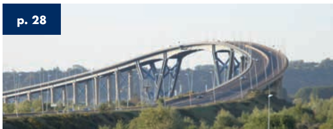
Viadotto sul Grand Canal Maritime Le Havre - Francia - Lunghezza 1.410 m
