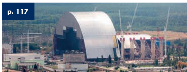
p. 117 2015 Nuovo Sistema di Contenimento Chernobyl - Ucraina - Dim. 257 m x 150 m x 109 m
