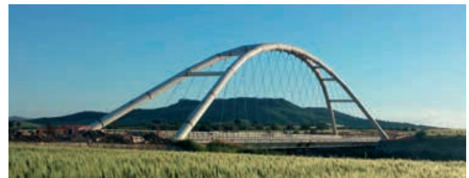
Ponte sulla Gravina Strada Statale Bradanica - Italia - Lunghezza 144 m
