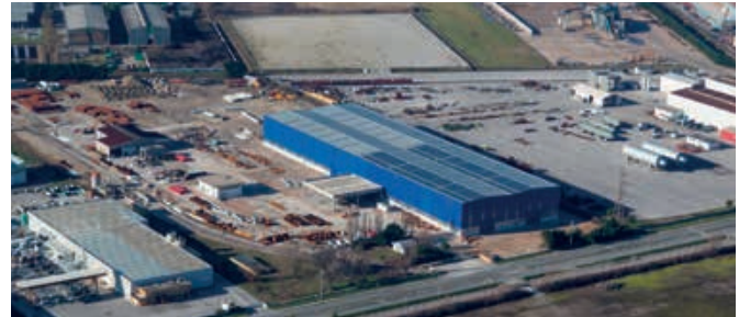
CIMOLAI SpA - S. Giorgio di Nogaro 2 - Italia Area totale 93.500 mq - Area coperta 16.000 mq
