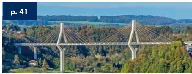
Viadotto Poya Friburgo - Svizzera - Lunghezza 850 m 2013
