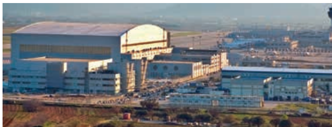
Hangar manutenzione aeroportuale Atene - Grecia - Area Coperta 24.000 mq 2001
