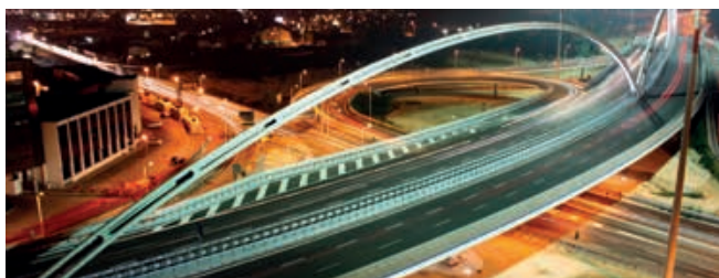
Ponte Darwin Padova - Italia - Lunghezza 550 m 2008
