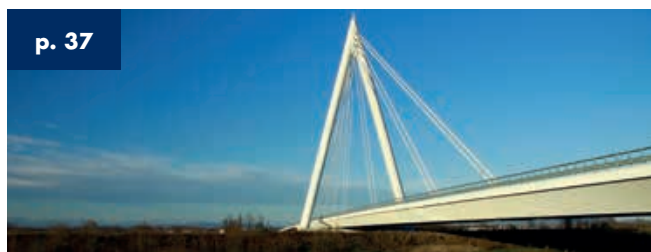
Ponte sull' Adige Valdastico sud - Italia - Lunghezza 1.000 m 2010
