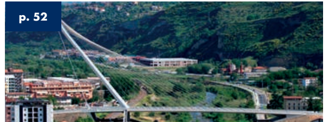
Ponte sul Crati Cosenza - Italia - Lunghezza 140 m
