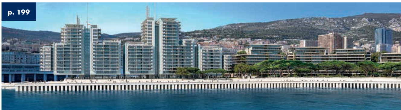
Mareterra Monaco - Principato di Monaco - Rivestimenti in alluminio 17.000 mq
