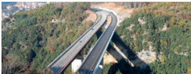
Viadotto Serra Autostrada A3 - Italia - Lunghezza 230 m
