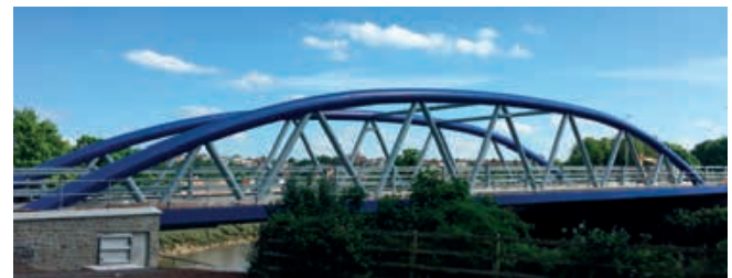
Ponte a Temple Quay Bristol - Regno Unito - Lunghezza 65 m
