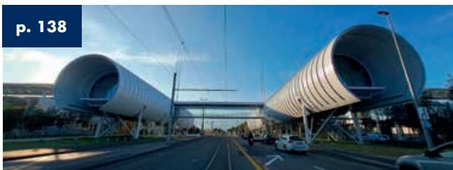
Cern New Gateway Ginevra - Svizzera - Facciate vetrate 2.060 mq 2023
