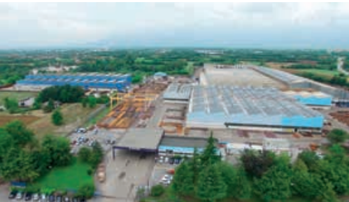
CIMOLAI SpA - Roveredo in Piano - Italia Area totale 121.000 mq - Area coperta 50.500 mq
