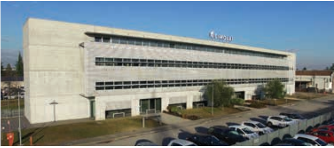
CIMOLAI SpA - Porcia - Italia UFFICI AMMINISTRATIVI
