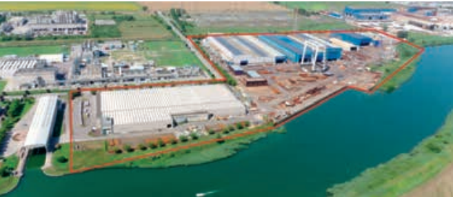
CIMOLAI SpA - S. Giorgio di Nogaro - Italia Area totale 182.000 mq - Area coperta 56.000 mq
