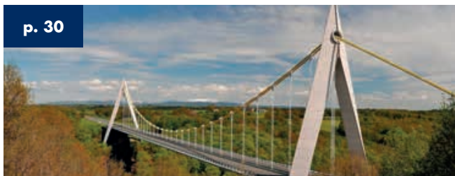
Viadotto Chavanon Merlines - Francia - Lunghezza 360 m
