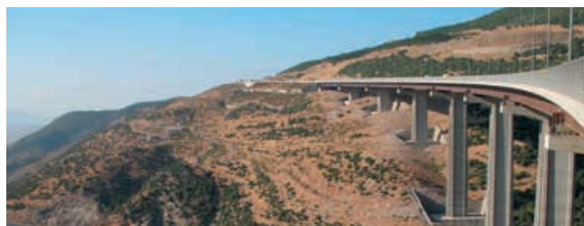
Viadotti sull'Autostrada Adana-Gaziantep Turchia - Lunghezza 5.200 m
