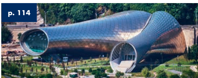
p. 114 2013 Auditorium Rihke Park Tbilisi - Georgia - Posti a sedere 600
