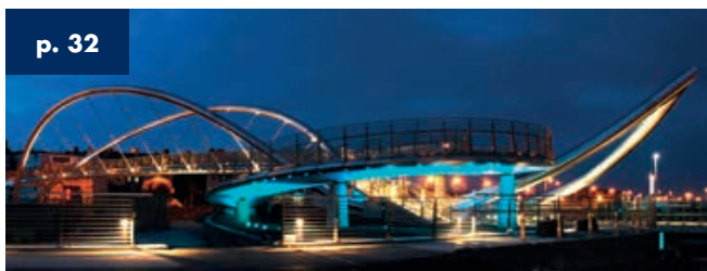
p. 32 Ponte Celtic Gateway Holyhead - Regno Unito - Lunghezza 170 m 2006
