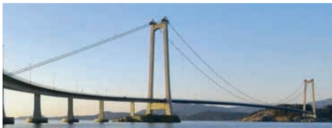
Ponte Bomla Stord - Norvegia - Lunghezza 500 m
