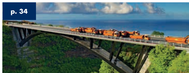
p. 34 Ponte sulla Ravine Fontaine St. Leu - La Riunione - Lunghezza 200 m 2009
