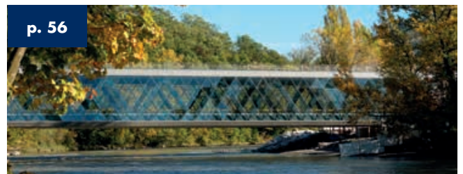
Ponte Ceva Ginevra - Svizzera - Lunghezza 82 m
