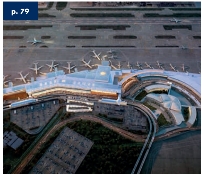
Ristrutturazione Ponte JFK T6 New York - USA - Lunghezza 903 m
